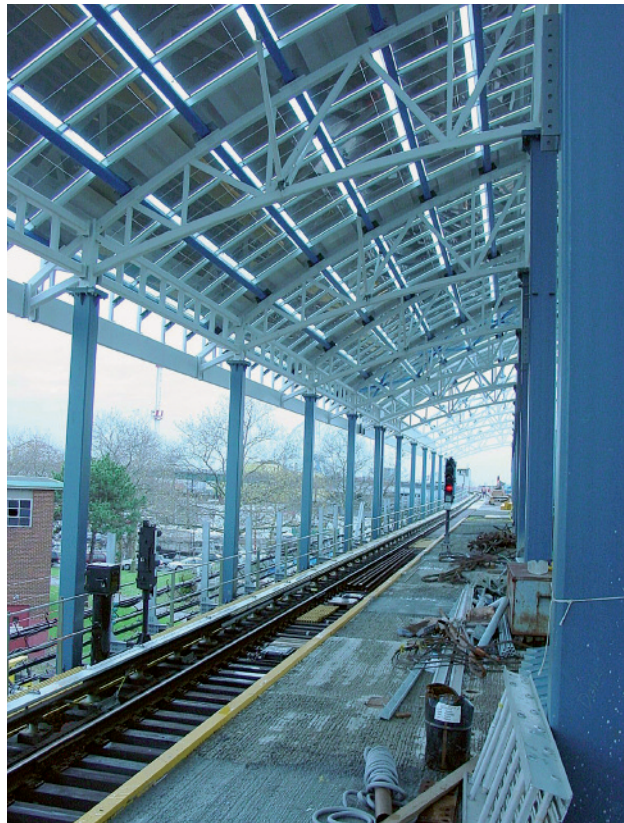
Figura 1.1 Il lucernario BIPV da 250 kW, Stillwell Avenue Station di New York: è uno dei maggiori impianti BIPV in America
