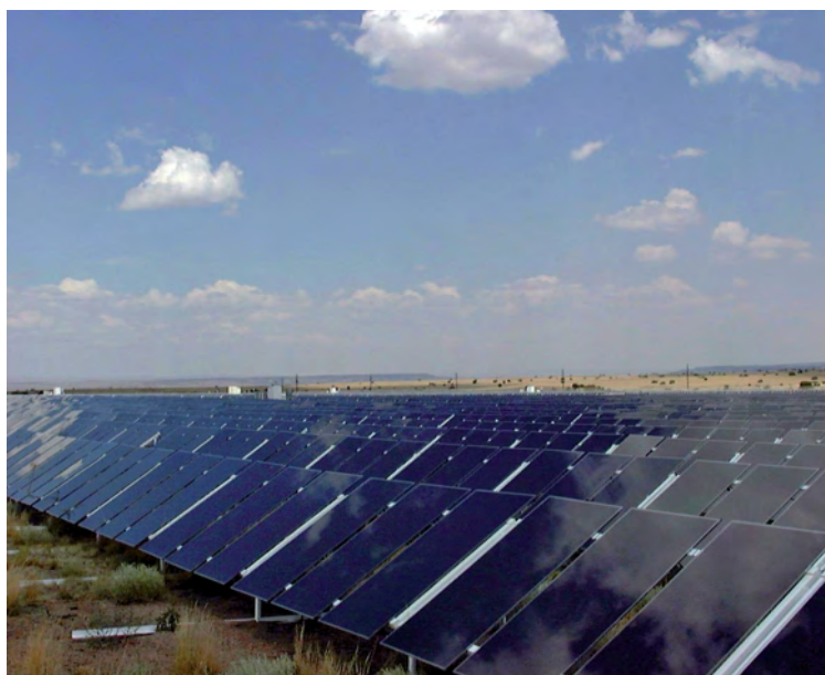
Figura 1.6 Gli utility panel (qui sono mostrati quelli forniti a Beck in Germania nel dicembre 2007), progettati da Nanosolar per la costruzione di centrali FV in campo aperto, forniscono energia al costo più basso mai riportato in fotovoltaica e possono essere prodotti e installati in tempi record
