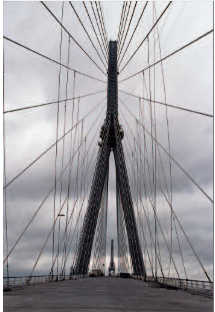
*F 1-2.- Ponte di Normandia sopra la Senna, Francia. Campata principale di 856 metri di luce. 1995. M. VIRLOGEUX. Fotografia scattata durante la costruzione.*
