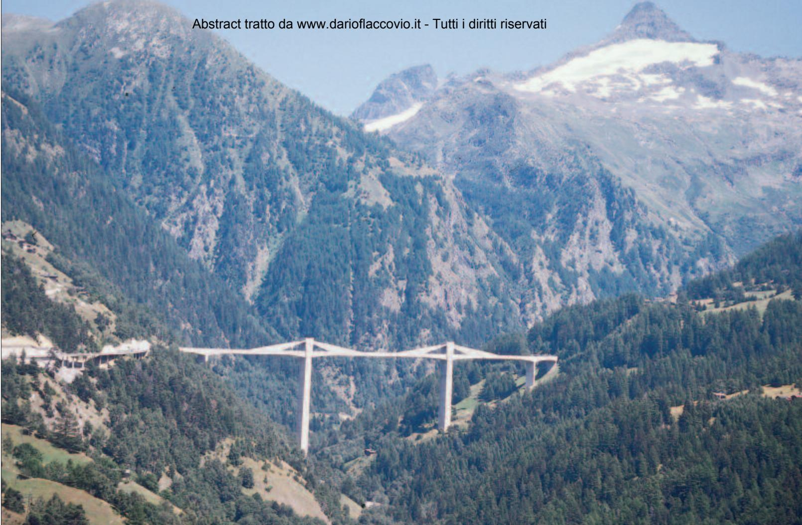
*F 1-5.- Il ponte di Ganter nel paesaggio alpino della strada del Sempione che attraversa le Alpi dalla Svizzera all'Italia. Campata principale di 174 metri di luce. 1982. C. MENN.*
