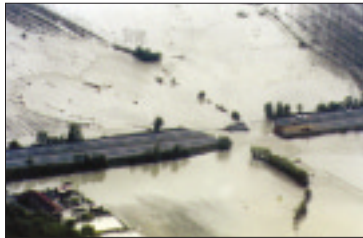
Figura 1 Autostrada Milano-Torino: ponte sulla Dora Baltea durante l'alluvione dell'autunno 2000.
