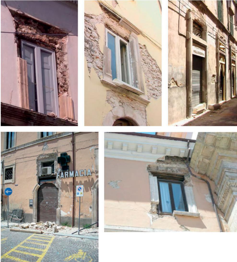
Figura 1.5. Danni a cornici di finestre e portali durante il sisma dell'Abruzzo del 2009
