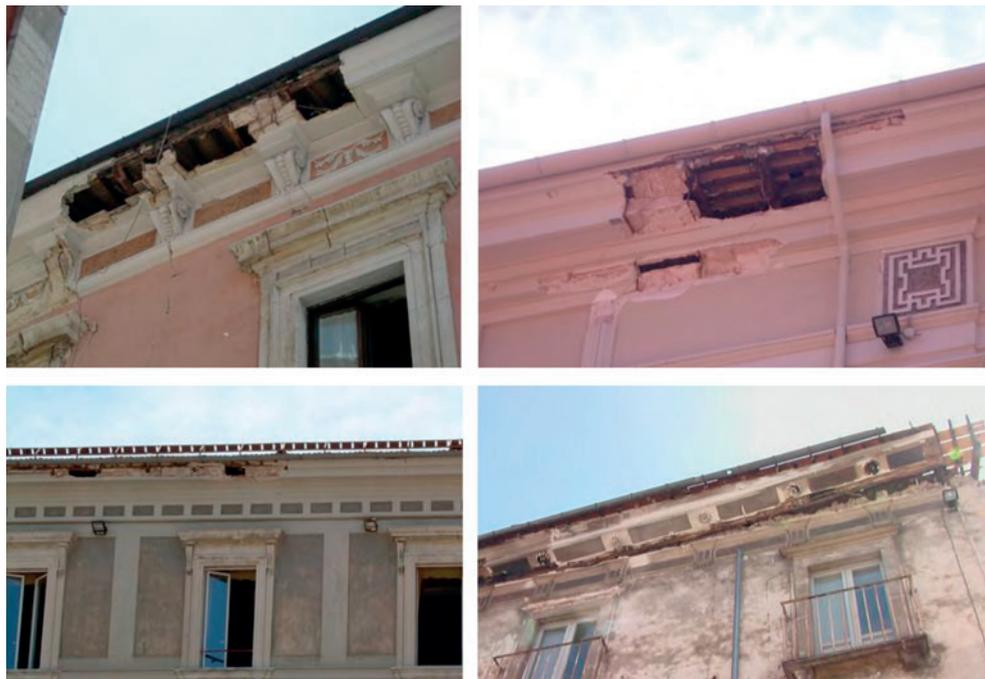
Figura 1.4. Danni a cornicioni durante il sisma dell'Abruzzo del 2009
