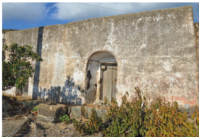
Foto in alto: Costruzione di ambienti per il ricovero degli animali Foto in basso: Dammuso con prospetto intonacato
