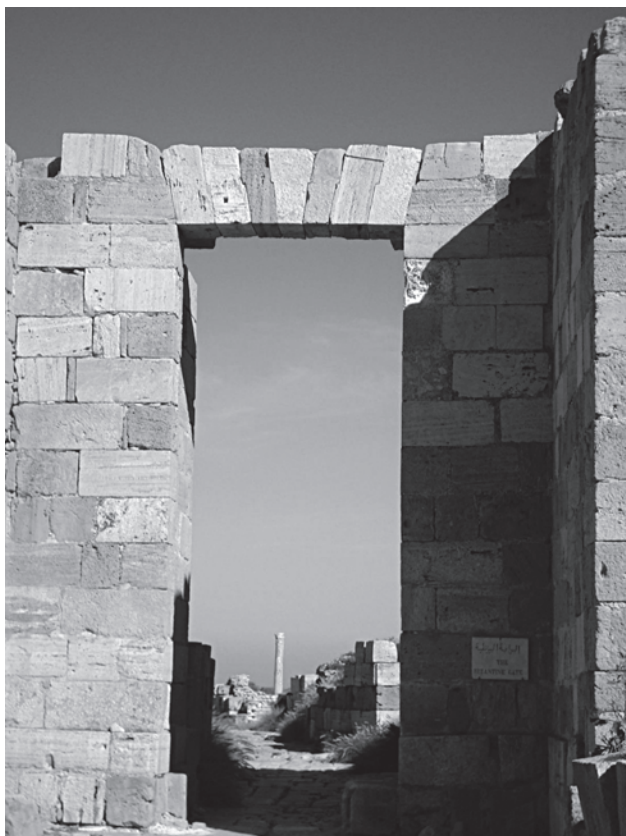
Figura 1.7. Leptis Magna (Libia), II secolo d.C. Piattabanda con cunei sagomati e disposti a incastro
