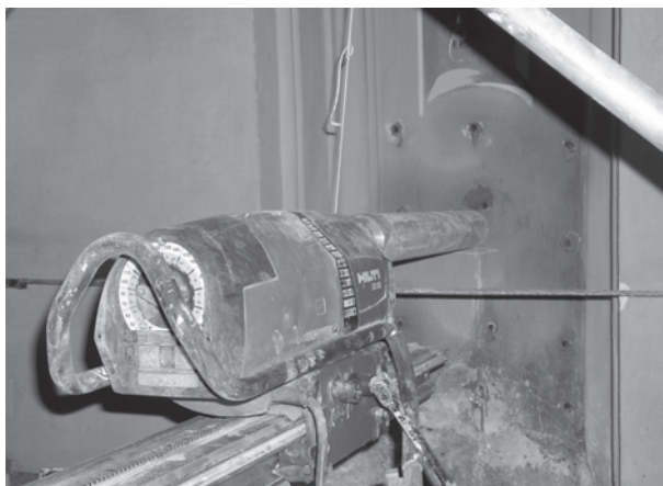
Figura 6.9. Carotatrice impiegata per la realizzazione di fori per la messa in opera di ancoraggi iniettati. Si noti la presenza di piccoli fori eseguiti attorno al foro principale, realizzati preventivamente per consolidare la muratura prima della carotatura e della realizzazione dell'ancoraggio
