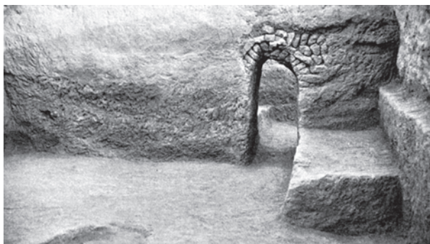
Figura 1.1. Stanza centrale della arch house , Tell Asmar (Iraq), III periodo proto dinastico (circa 2500 a.C.). L'immagine mostra uno dei primi esempi di arco a conci (Frankfort, 1934, p. 15)
