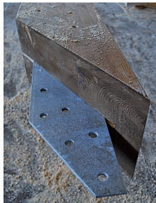
Figura 2.4 Esempio di una sezione ridotta dalle lavorazioni di testa nella catena in legno lamellare di una capriata
