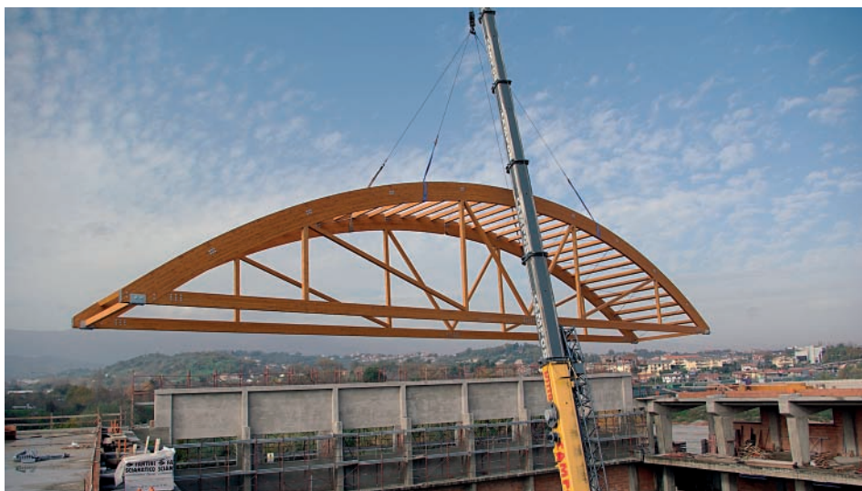
Figura 1.26. Varo di un'intera campata preassemblata in cantiere. L'arco alto 8 m, a spinta eliminata dalla catena in legno, non poteva chiaramente essere trasportato. È inoltre evidente che montare l'orditura principale e secondaria in quota sarebbe stato molto più impegnativo e meno sicuro per gli operatori. Peso 25 ton. Area in pianta 330 m 2 . Lunghezza in pianta 46 m
