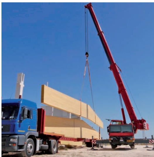
Figura 1.24. Fase di scarico in cantiere eseguita con autogrù da 80 ton
