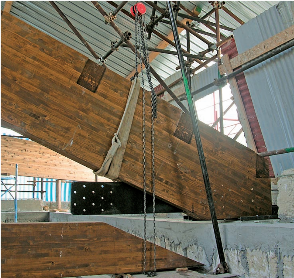
Figura 3.39. Vista dell'appoggio della capriata in fase di montaggio. Si può notare la rastremazione del puntone alla base, necessaria per ottenere un appoggio orizzontale, e la lama interna, in attesa ancora della catena, che con la sua fresatura indebolisce ulteriormente la sezione del puntone
