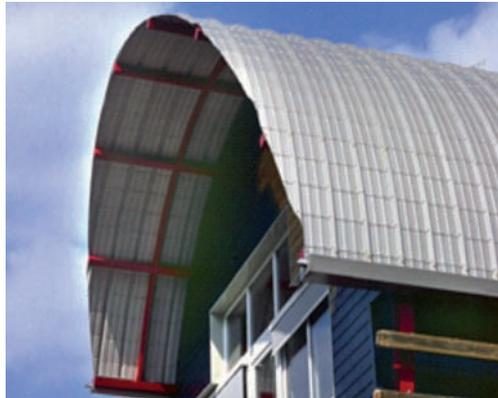
Figura 5.15. Copertura ad arco con lamiera zincata
