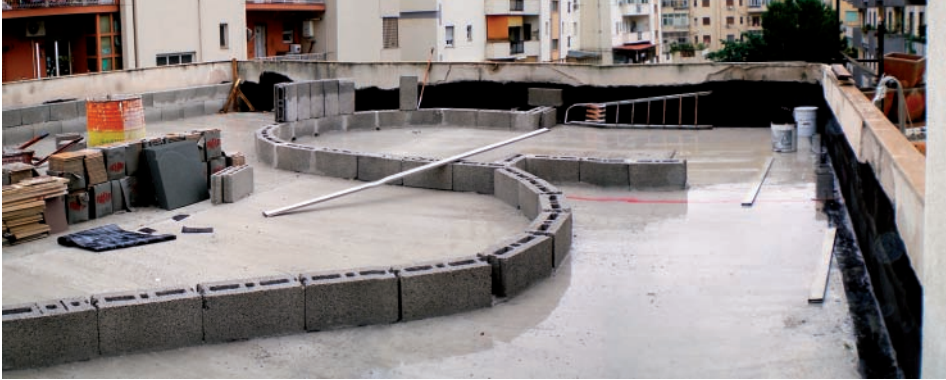
Figura 3.32. Disposizione dei cordoli per l'individuazione delle aree a verde e, a sinistra, contromuro di protezione del parapetto (fonte: archivio Laboratorio di Architettura Ambientale di Catania)
