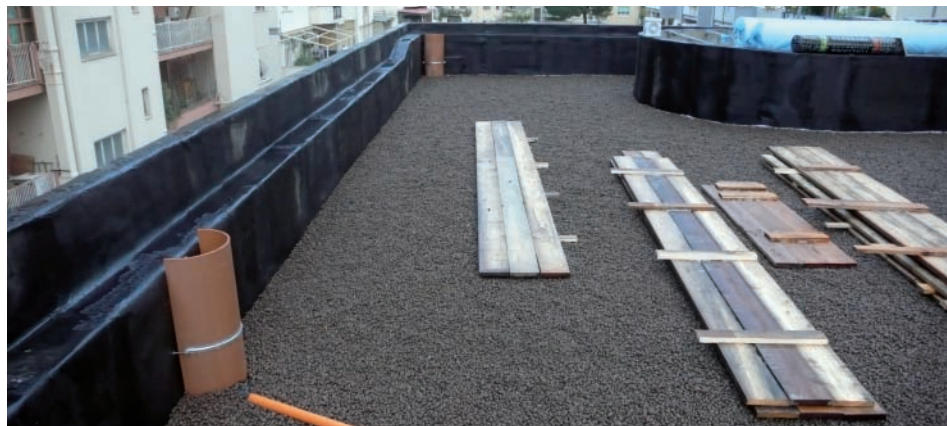
Figura 3.35. Posa in opera della guaina antiradice, particolare del contromuro. Saranno successivamente applicati dei paletti su cui verrà fissata la rete di protezione coperta in seguito con la siepe perimetrale. Mettere in sicurezza la terrazza è fondamentale quando si solleva il piano di calpestio e il muro parapetto non svolge più la sua funzione protettiva (fonte: archivio Laboratorio di Architettura Ambientale di Catania)
