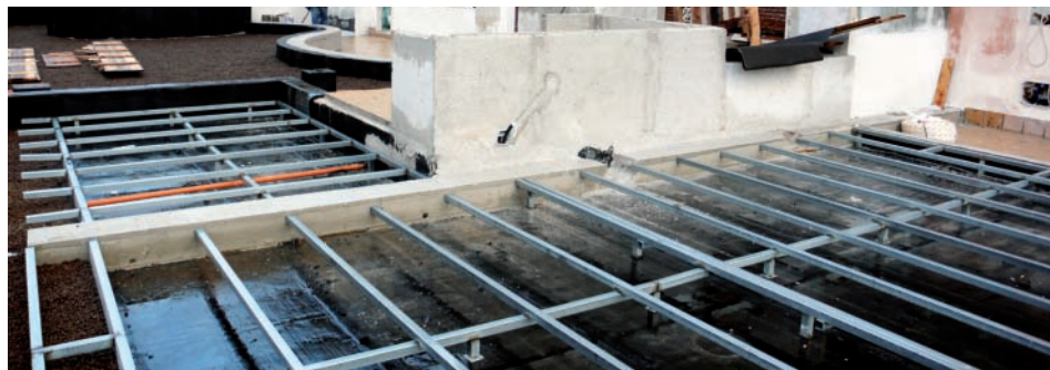
Figura 3.36. Telai di sostegno della pavimentazione galleggiante (fonte: archivio Laboratorio di Architettura Ambientale di Catania)
