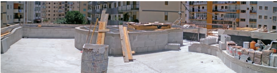
Figura 3.33. Fase costruttiva zona Spa
