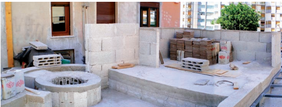
Figura 3.34. Fase costruttiva zona doccia e cucina esterna (fonte: archivio Laboratorio di Architettura Ambientale di Catania)
