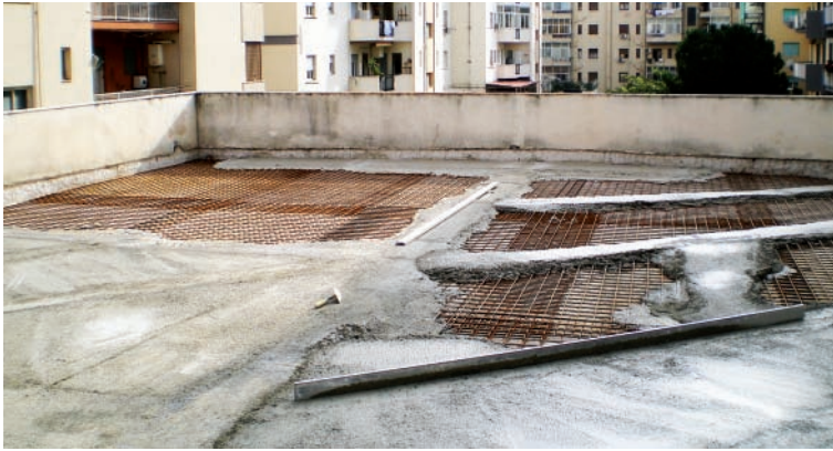
Figura 3.29. Rafforzamento del solaio (fonte: archivio Laboratorio di Architettura Ambientale di Catania)
