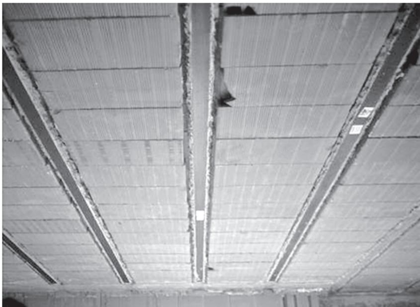
Figura 1.56. Rinforzo dei travetti di un solaio latero-cementizio con l'impiego di lamine pultruse in fibra di carbonio (fonte: Mapei)
