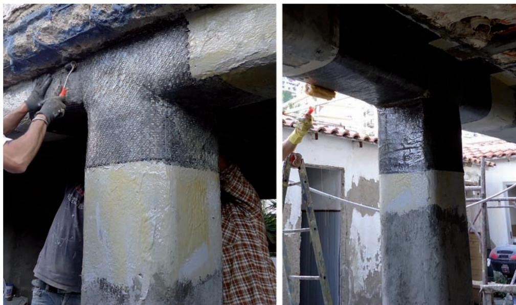
Figura 3.13. Nodo trave-colonna. A sinistra: rinforzo del pannello di nodo. A destra: confinamento col rinforzo a taglio delle zone critiche
