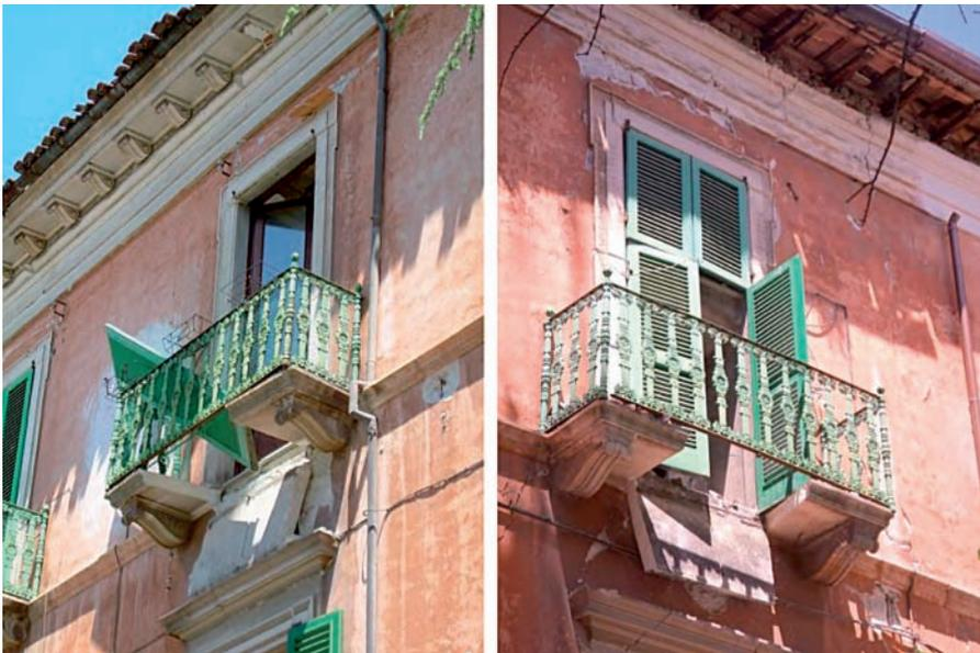
Figura 2.54. Danno a balcone in pietra durante il sisma dell'Abruzzo del 2009 (fonte: *Linee guida per la riduzione della vulnerabilità di elementi non strutturali arredi e impianti*, giugno 2009)
