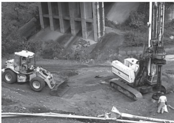
Figura 1.1. Attrezzatura pali trivellati
