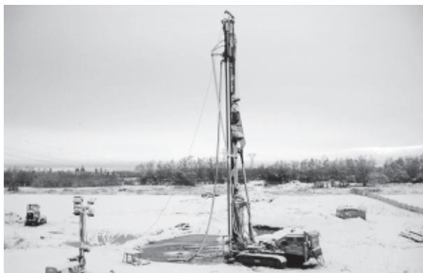
Figura 6.2. Perforatrice per *jet-grouting*
