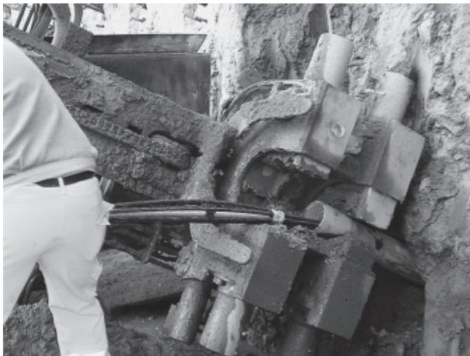
Figura 4.9. Fase d'inserimento del tirante nella perforazione
