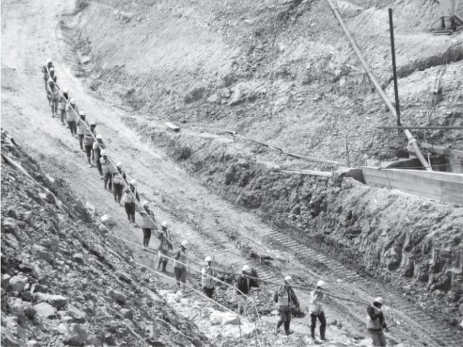
Figura 4.7. Movimentazione tiranti in cantiere
