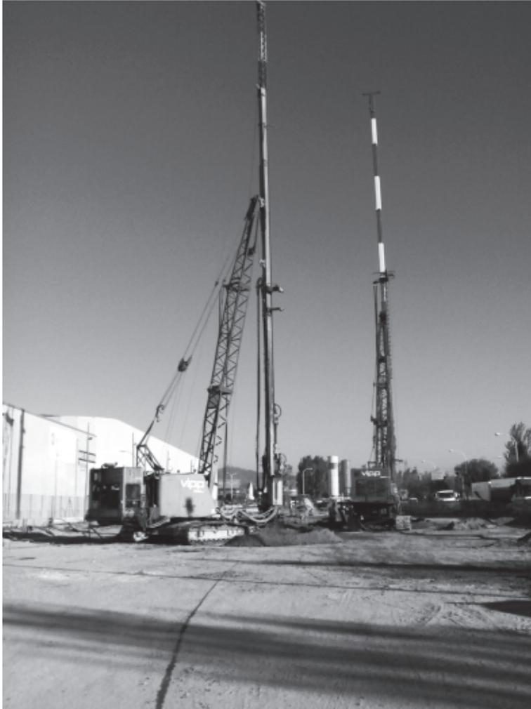
Figura 6.4. Escavatori Link-Belt con antenna da *jet-grouting*
