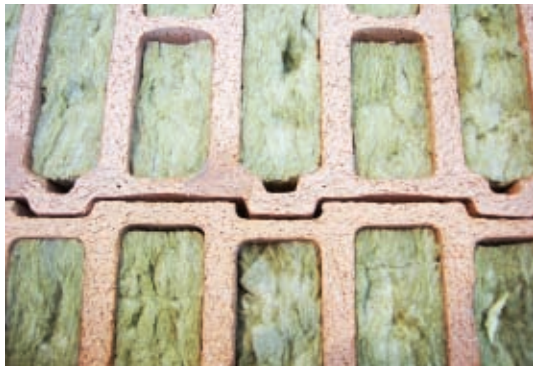
Figura 2.10 Dettaglio dell'isolamento in lana di roccia inserito in blocchi compositi di laterizio
