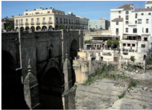
Figura 3.8 Città con pareti massive che si sviluppano direttamente a partire dalla roccia per ottenere i benefici di inerzia termica e di raffrescamento diurno (Ronda, Spagna)
