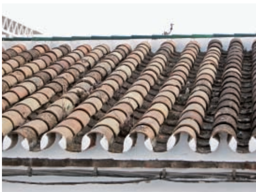
Figura 2.13 Copertura realizzata con laterizio a tegole curve
