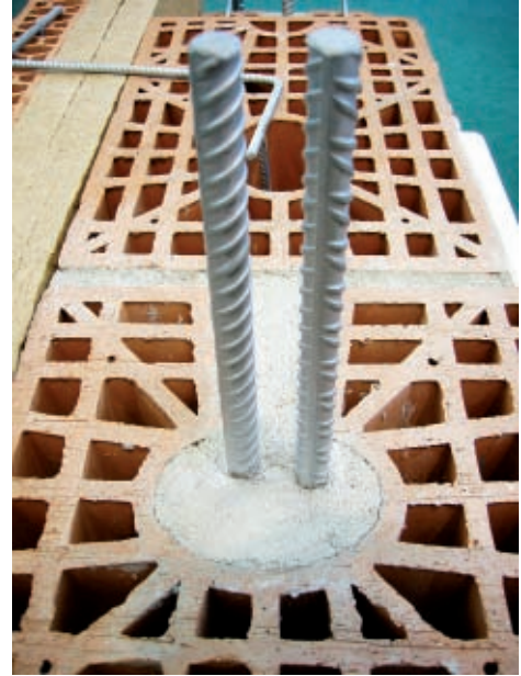
Figura 2.5. Isolamento dei ferri di armatura verticali
