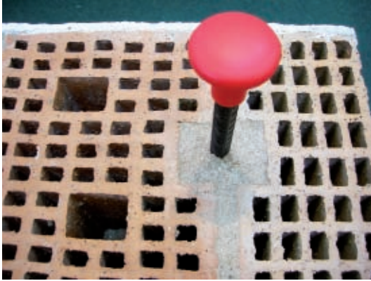
Figura 2.4 Protezione e isolamento dei ferri di armatura verticali
