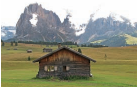
Figura 3.6 Utilizzo del legno di colore scuro per migliorare l'accumulo di calore della parete (Compatsch, Italia; foto di Evy Lai)
