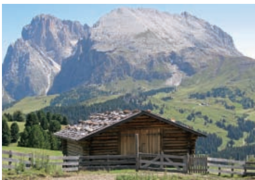
Figura 3.5 Rivestimento esterno di pareti in legno per trattenere il più possibile il calore prodotto all'interno dell'ambiente e per isolare in modo uniforme le pareti in pietra (Compatsch, Italia; foto di Evy Lai)
