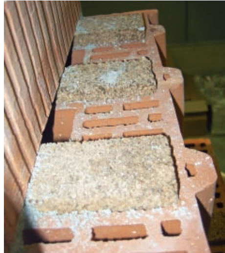
Figura 2.9 Parete in blocchi compositi in laterizio e materiale isolante
