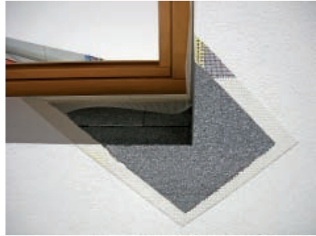
Figura 8.14 Inserimento di armature diagonali sugli angoli
