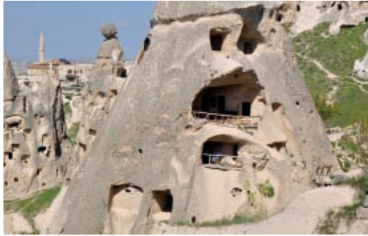
Figura 3.7 Città sotterranee con pareti ricavate direttamente dalla roccia e dal terreno per sfruttarne i benefici di inerzia termica e raffrescamento passivo (Cappadocia, Turchia; foto di Elena Ciucci)
