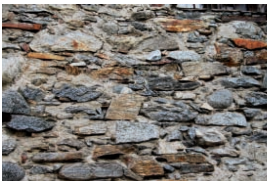
Figura 3.3 Parete mista in sassi e pietra di grande spessore (Renon, Italia)
