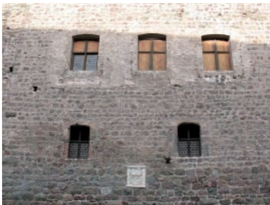
Figura 3.1 Involucro opaco in pietra di tipo massivo (Bolzano, Italia; foto di Alberto Pizzi)
