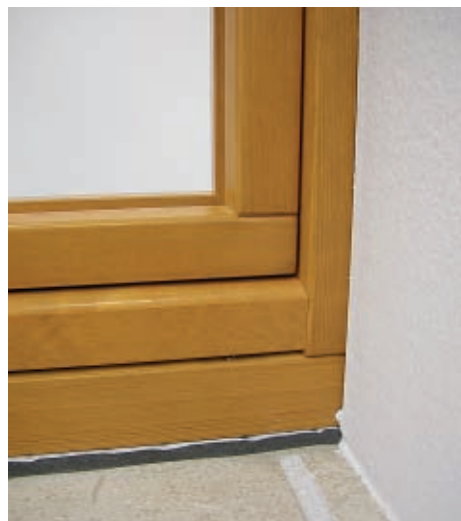
Figura 8.16 Inserimento di guarnizioni nei davanzali gettati in opera per impedire le infiltrazioni d'aria
