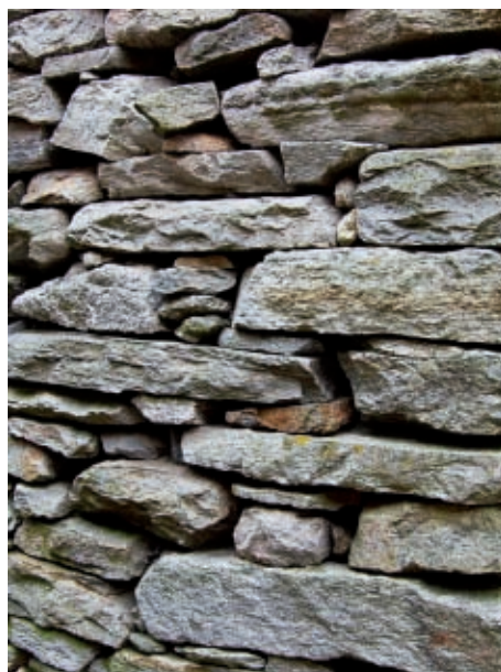
Figura 3.4 Parete in pietra di grande spessore (Renon, Italia)
