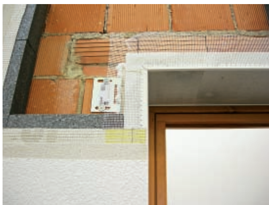
Figura 8.12 Posa in opera di un serramento in una parete in muratura: per evitare la formazione di ponti termici è stato inserito uno strato di isolante in fibra di legno tra il vano murario e il telaio ligneo della finestra. L'isolante è poi nastrato per evitare infiltrazioni d'acqua
