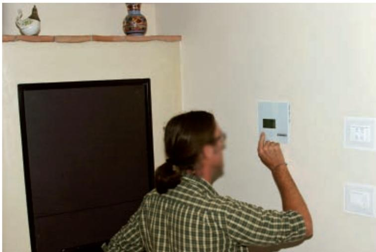
Figura 9.10. Impostazione dei parametri su apposito quadro di comando. Sul monitor è inoltre possibile vedere la temperatura rilevata istante per istante in camera di combustione, nello scambiatore, e nel serbatoio di accumulo termico collocato in un apposito locale (fonte: CaloreNaturale-FuocoStufeCamini)
