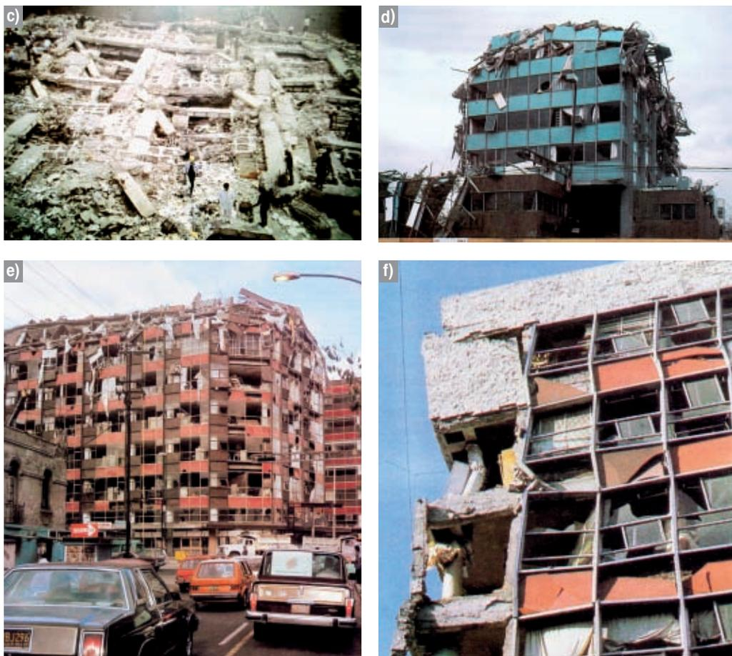
Figura 1.7. Collasso di edifici multipiano ad elevate flessibilità e masse d'impalcato
