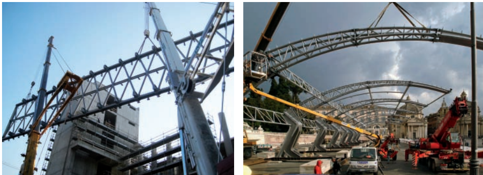
Figura 8.10. Esempi di montaggi dei conci strutturali
