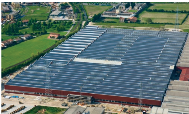
Figura 3.19. Esempio di coperture fotovoltaiche su stabilimento industriale
