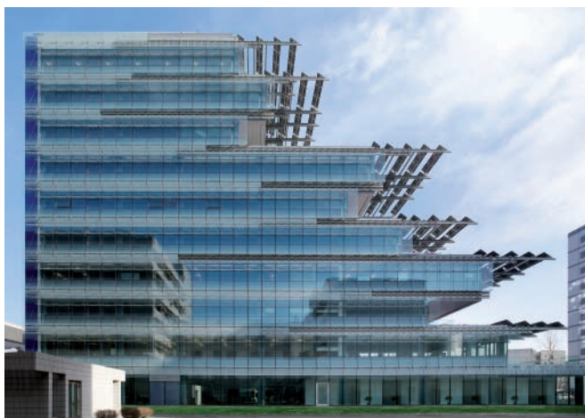
Figura 3.20. Prospetto edificio SIEEB (Pechino)
