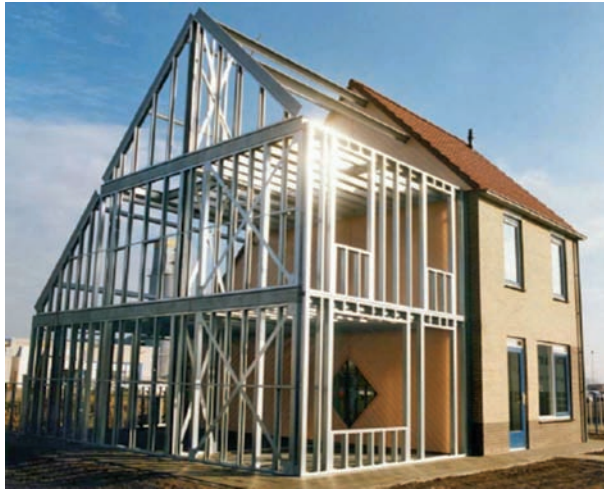
Figura 8.13. Vista dello “scheletro strutturale” di un edificio realizzato mediante la tecnica del Baloon Frame
