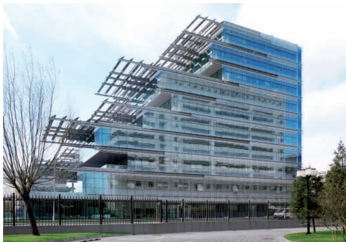
Figura 3.21. Prospetto edificio SIEEB (Pechino)
