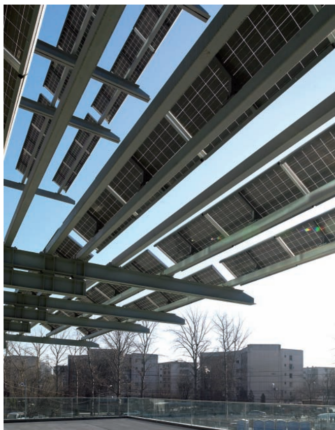
Figura 3.22. Dettaglio sui pannelli fotovoltaici dell'edificio SIEEB (Pechino)
