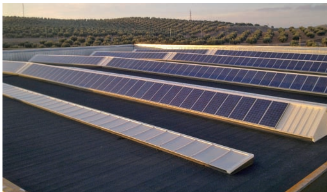
Figura 3.18. Esempio di fissaggio moduli fotovoltaici alle strutture di copertura
