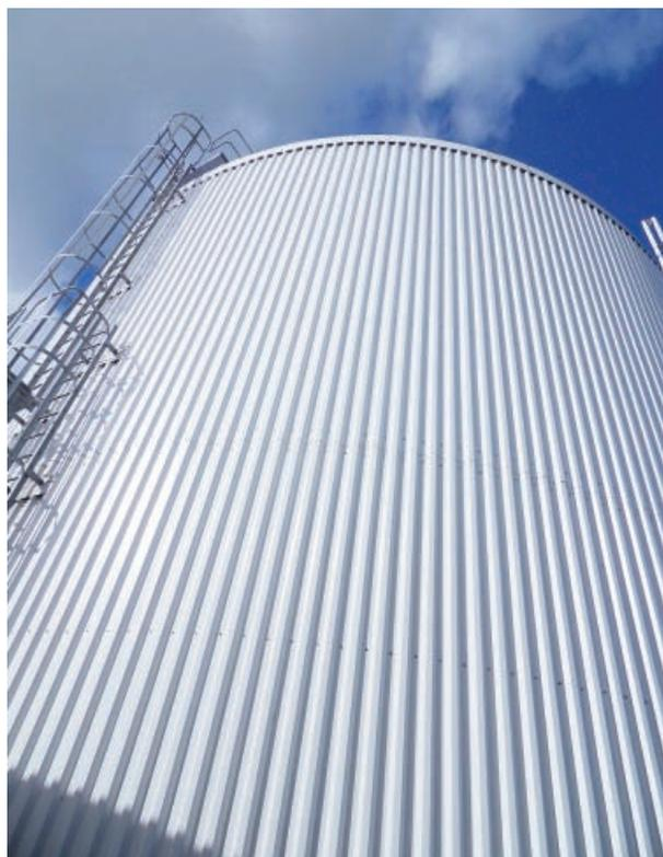
Figura 2.5. Un accumulo giornaliero di grande dimensione nell'impianto solare di Marstal, Danimarca (foto: Riccardo Battisti)
