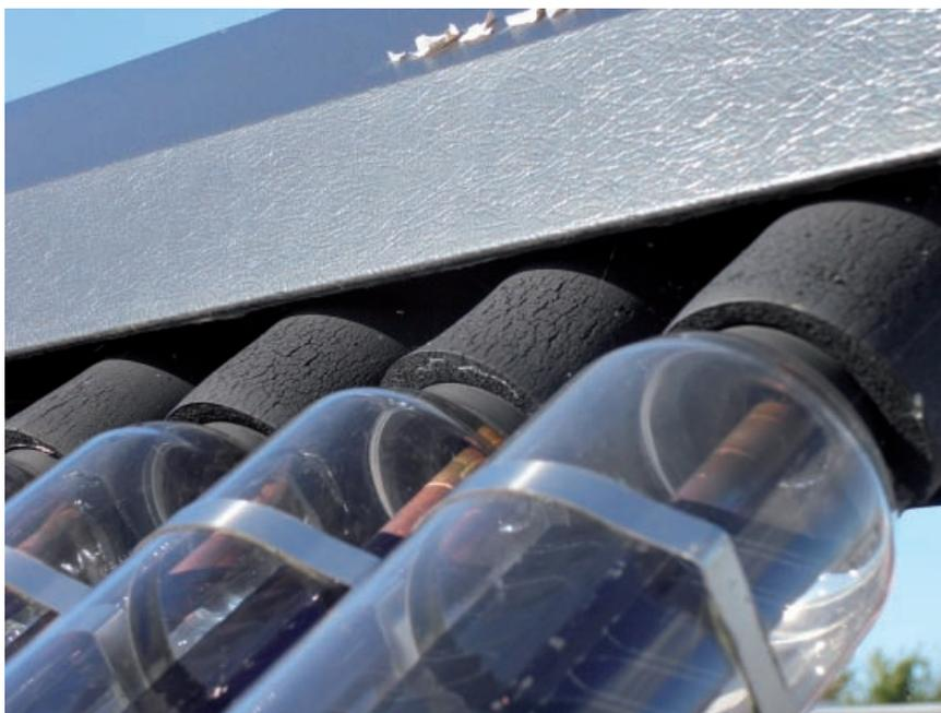
Figura 3.6. Particolare di un collettore solari a tubi sottovuoto (foto: Riccardo Battisti)
