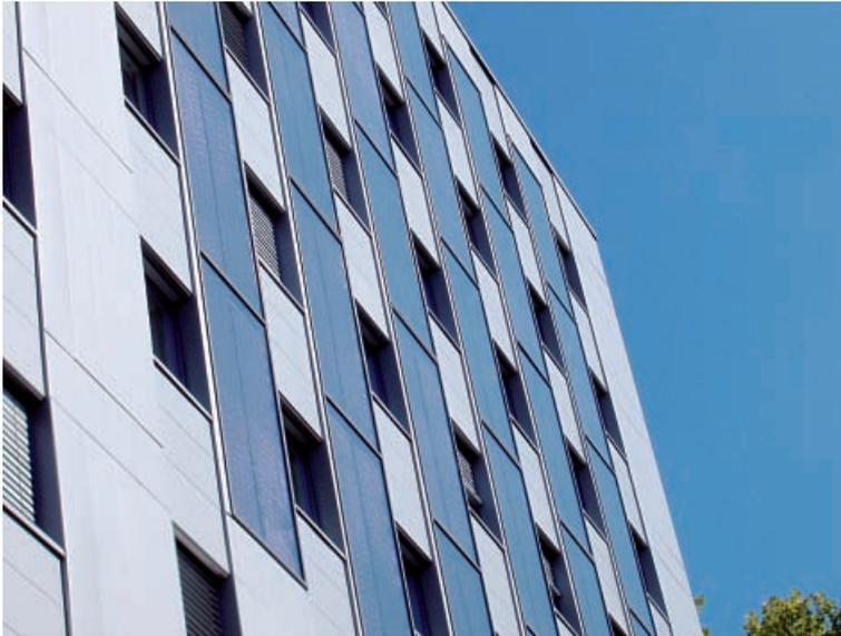
Figura 1.10. Impianto solare termico in facciata realizzato in Austria per uno studentato universitario (foto: Riccardo Battisti)
