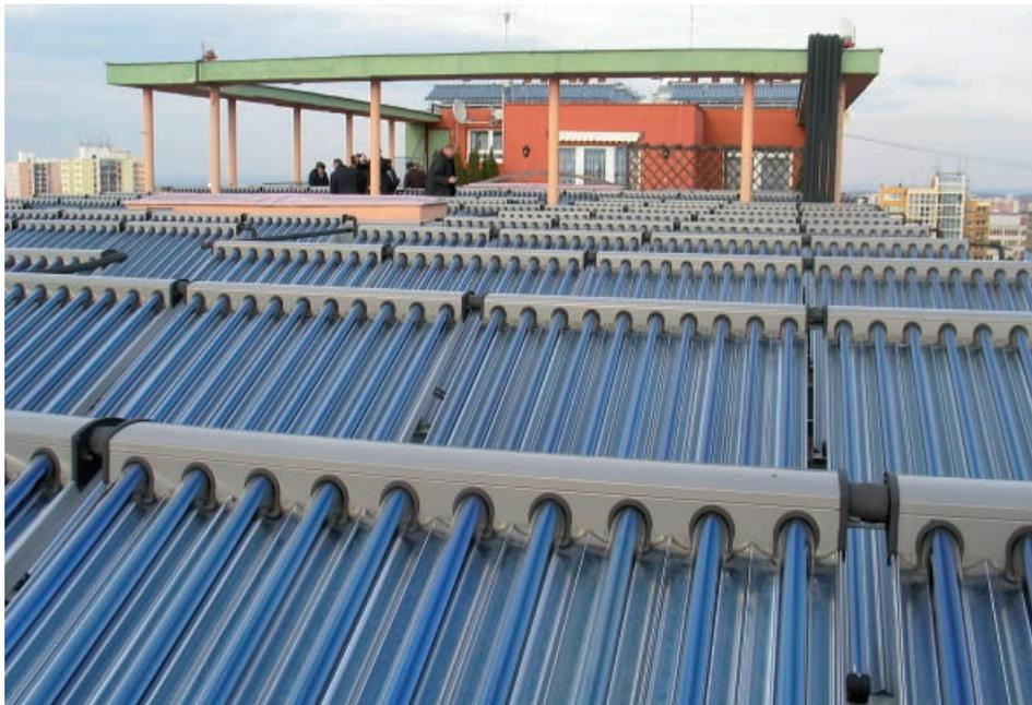
Figura 3.5. Impianto con collettori solari a tubi sottovuoto (foto: Riccardo Battisti)
