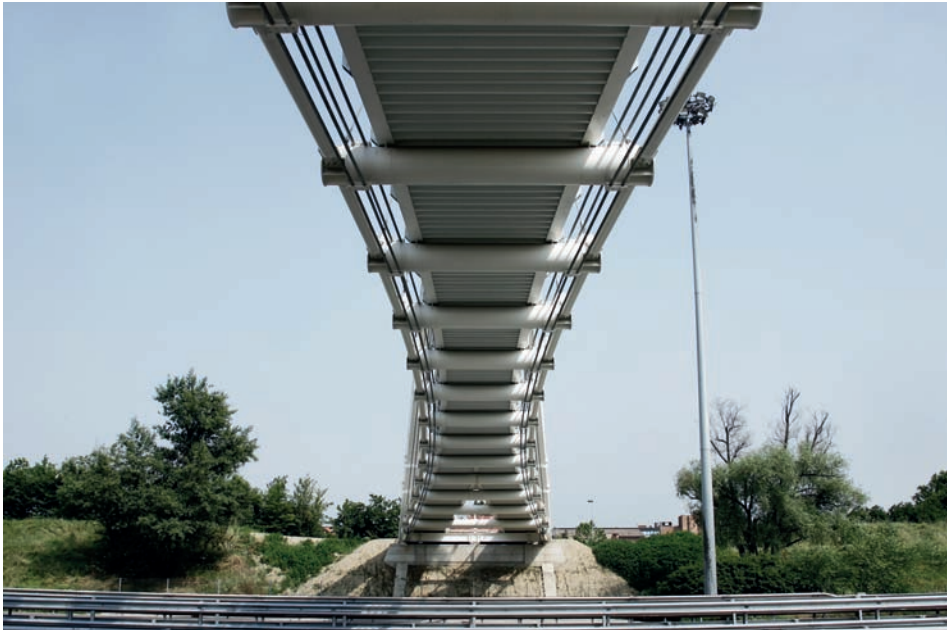
Figura 1.8. Vista delle funi spiroidali che eliminano la spinta dei cavalletti (© Fondazione Promozione Acciaio)
