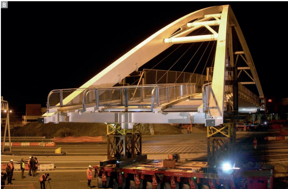
Figura 1.10. Ponte ciclopeditoneo: fasi a) della realizzazione (© Studio Majowiecki); b) del varo (© Studio Majowiecki)
