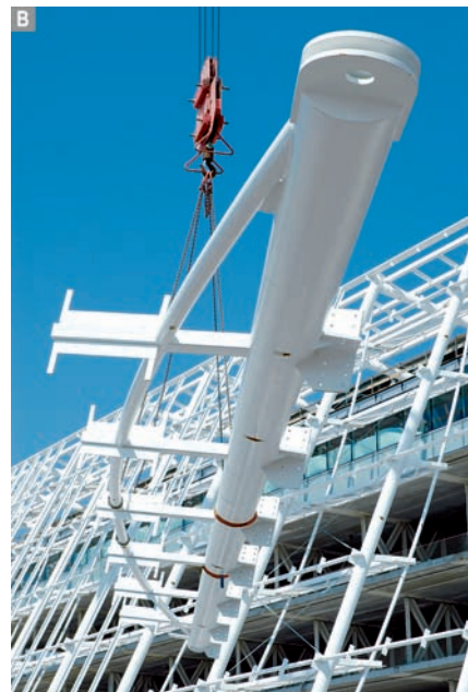
Figura 1.3. Fasi di montaggio: a) impiego contemporaneo di due gru (© Ocam S.r.l.); b) sollevamento di un elemento principale (© TenarisDalmine)
