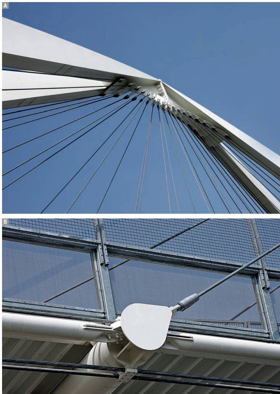
Figura 1.9. Dettagli: a) sistema di stralli convergenti (© Fondazione Promozione Acciaio); b) giunto bullonato tra i cavalletti (© Fondazione Promozione Acciaio)
