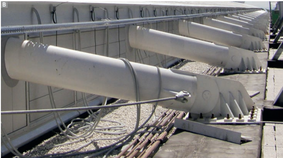
Figura 1.4. Particolare delle cerniere cilindriche: a) attacco degli elementi principali (© Fondazione Promozione Acciaio); b) attacco dei puntoni di copertura (© Ocam S.r.l.)
