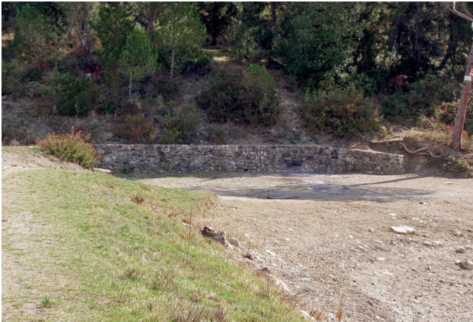
Figura 2.31. Esempio di soglia con immissione diretta nel canale
