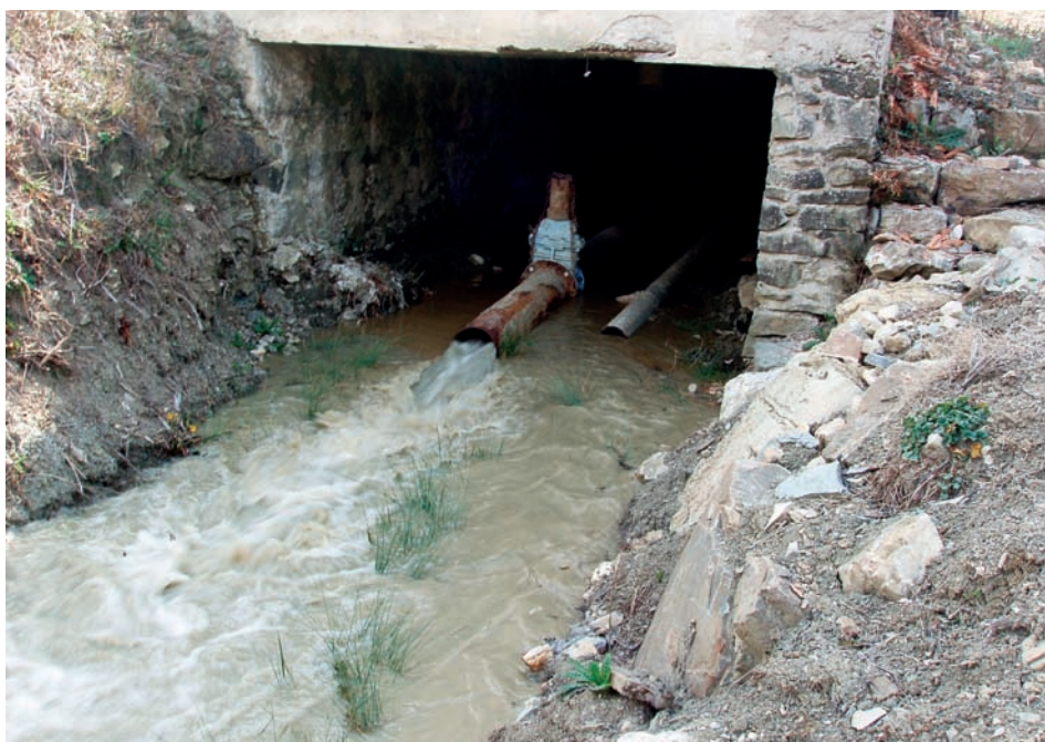
Figura 4.12. Operazione di prova saracinesca di scarico
