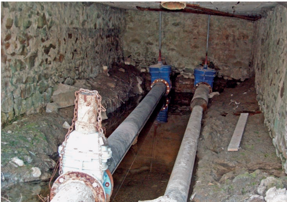
Figura 4.13b. Saracinesche sostituite
