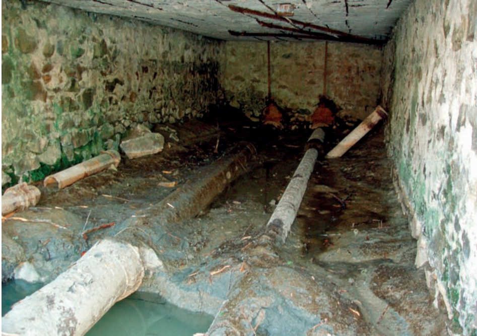
Figura 4.13a. Saracinesche da sostituire
