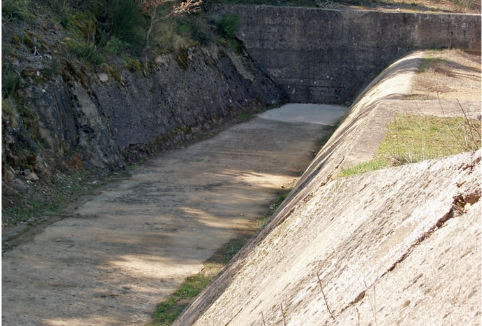
Figura 2.28. Esempio di soglia sagomata con profilo Creager
