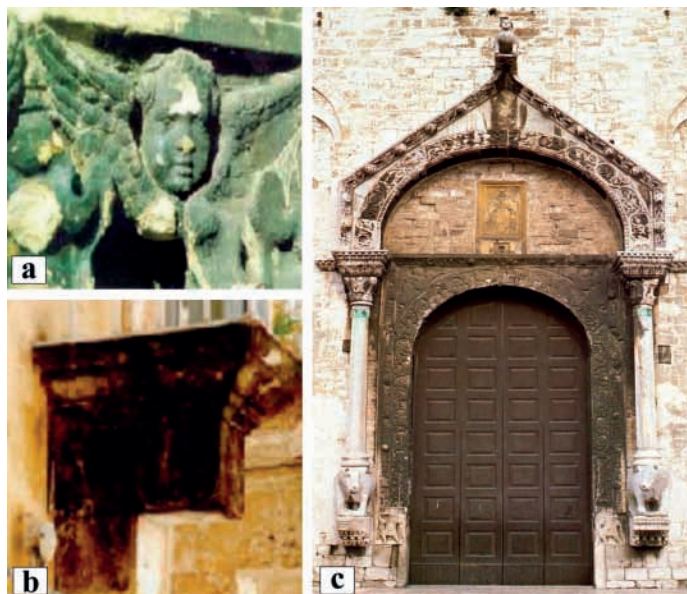
Figura 1.21 Esempi di croste nere su alcuni manufatti architettonici: a) putto alato (Lanciano); b) veletta di balcone (Siracusa); c) portale della Basilica di S. Nicola (Bari)
