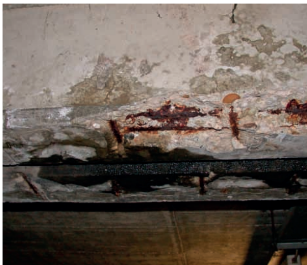
Figura 1.20 Carbonatazione del calcestruzzo di una struttura in c.a. con evidenze di ossidazione dell'armatura metallica
