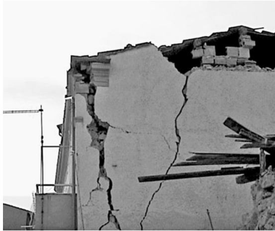
Figura 1.1. Edificio a S. Giuliano di Puglia – Molise 2002
