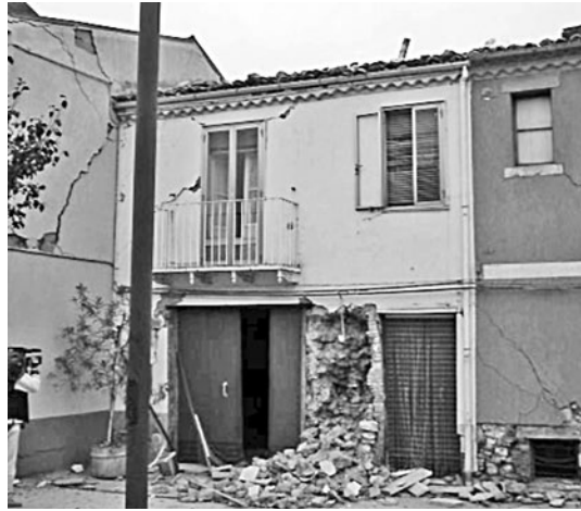
Figura 1.6 Edificio a S. Giuliano di Puglia – Molise 2002
