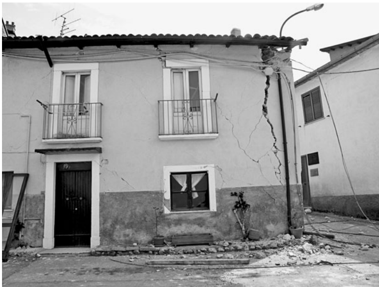
Figura 1.2. Edificio a L'Aquila – frazione Tempera – Abruzzo 2009
