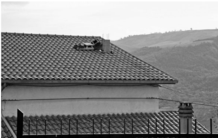
Figura 1.15. Il danneggiamento degli elementi secondari – Molise 2002
