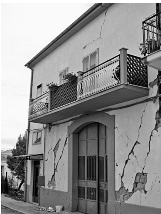
Figura 1.5 Edificio a S. Giuliano di Puglia – Molise 2002
