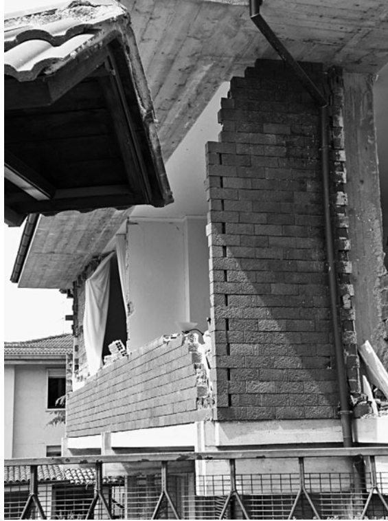
Figura 1.14. Il ribaltamento delle tamponature degli edifici in cemento armato – Abruzzo 2009
