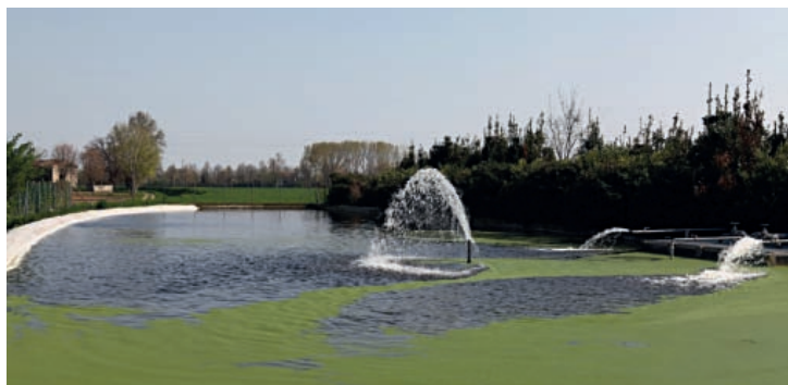
Figura 4.5 Impianto di lagunaggio aerobico (fonte: www.centrovenetoservizi.it )
