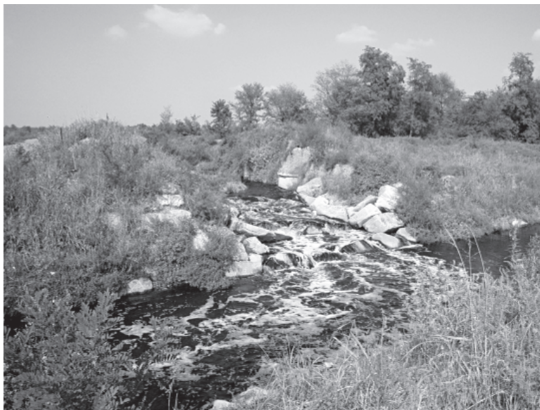
Figura 1.2. Scarico dell'effluente del depuratore di S. Antonino Ticino (VA), nel torrente Arno: gli scarichi di tintorie non riescono ad essere sufficientemente trattate dal depuratore
