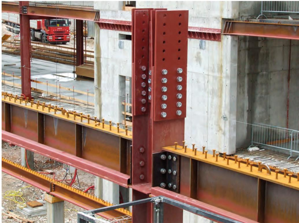
Figura 1.20 - Travi composte edificio multifunzione a Rovereto (TN).
