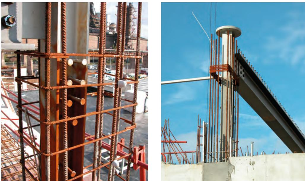
Figura 1.26 - Colonna con connettori edificio multipiano per uffici in Lussemburgo.
