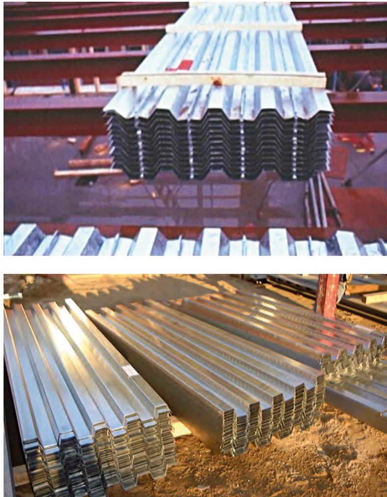
Figura 1.16 - Lamiera metalliche pronte per la posa in opera a mano.
