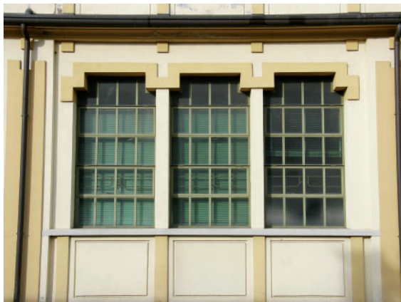
Figura 1.13. Serramento in ferro di un vecchio opificio ristrutturato
