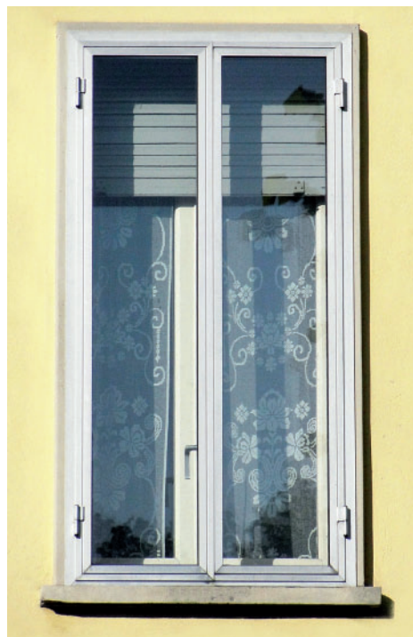
Figura 1.15. Serramento esterno aggiunto come protezione
