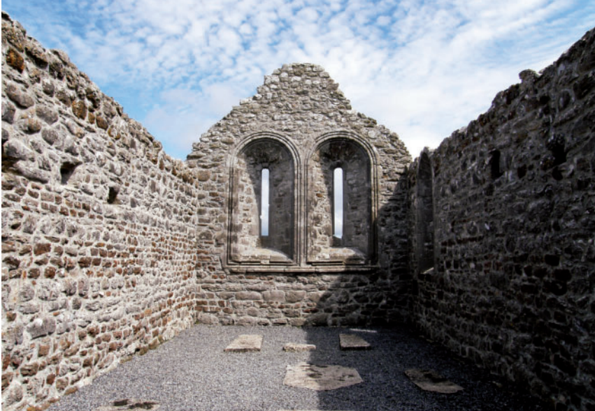
Figura 1.5. Resti dell'abbazia di Clonmacnoise (IRL) con due finestrelle absidali a forma di fessura e ampia strombatura (foto di proprietà dell'autore)
