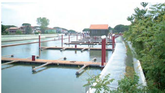
Figure 1 e 2 Porto fluviale di Montignoso, sul fiume Versilia
