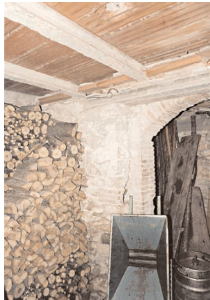
Figura 1.25 Ambito recente, solaio in latero-cemento
