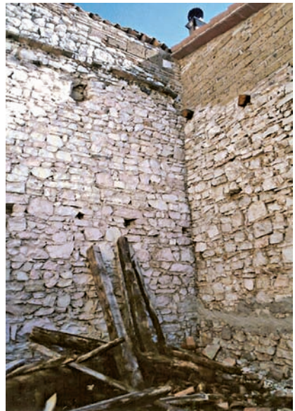
Figura 1.12 Ambito antico, tracce dell'antica copertura e della successiva sopraelevazione; si noti il distacco all'angolo tra le due muraure
