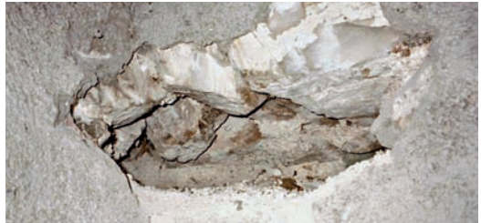
Figura 1.10 Saggio nella muratura
