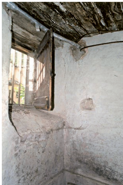
Figura 1.13 Ambito antico, solaio realizzato con tavolame
