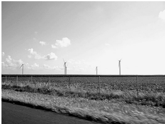
Figura 1.1. Parco di aerogeneratori eolici
