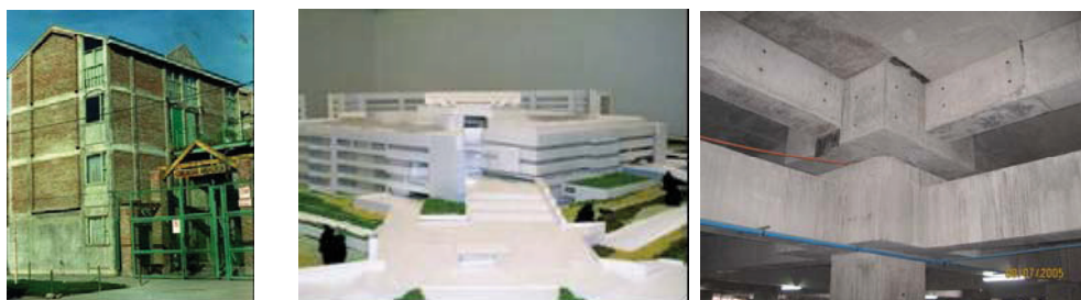
Figura 29. A sinistra: edificio popolare della Comunidad Andalucia a Santiago, con HDRB (1992, prima applicazione dell'isolamento sismico in Cile). Al centro e a destra: il Nuevo Hospital Militar La Reina (80000 m 2 ), durante la costruzione a Santiago (2005) con 114 HDRB e 50 LRB.
