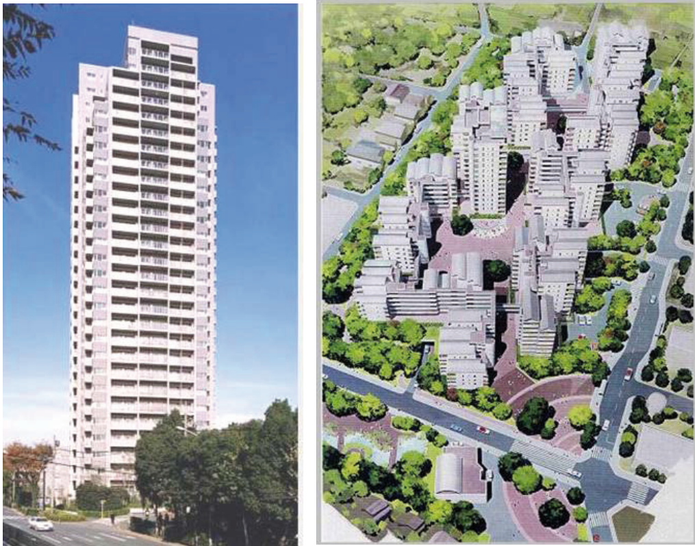
Figura 3. A sinistra: edificio di 87,4 m d'altezza, che è stato isolato a Tokyo nel 2000 (prima applicazione giapponese dell'isolamento a grattacieli). A destra: schizzo del complesso costituito da 21 edifici di 6÷14 piani che sorgono tutti su un'unica grande piattaforma isolata (denominata artificial ground ) a Sagamihara, nell'area di Tokyo.
