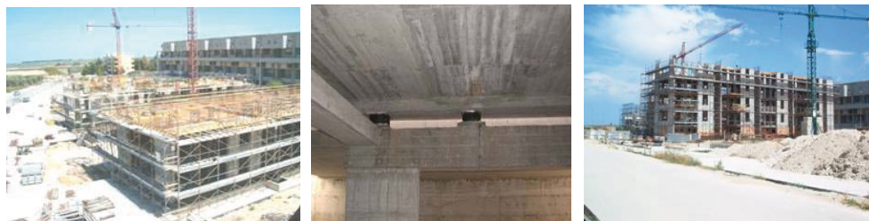
Figura 20. I nuovi edifici isolati del Quartiere San Samuele di Cerignola (a sinistra in giugno 2005 ed al centro in settembre 2005) e vista di due dei 124 HDRB installati alla sommità del piano interrato.
