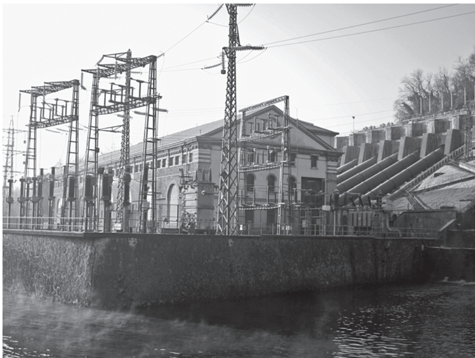
Figura 1.1. La centrale "Bertini" di Porto D'Adda (MB), prima grande centrale idroelettrica italiana
